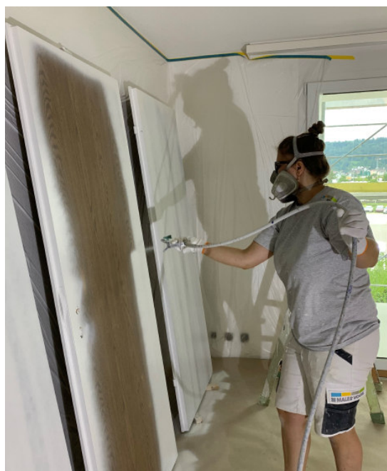
Eine Mitarbeiterin der Maler Vogel AG bei der Airless-Spritzapplikation.
