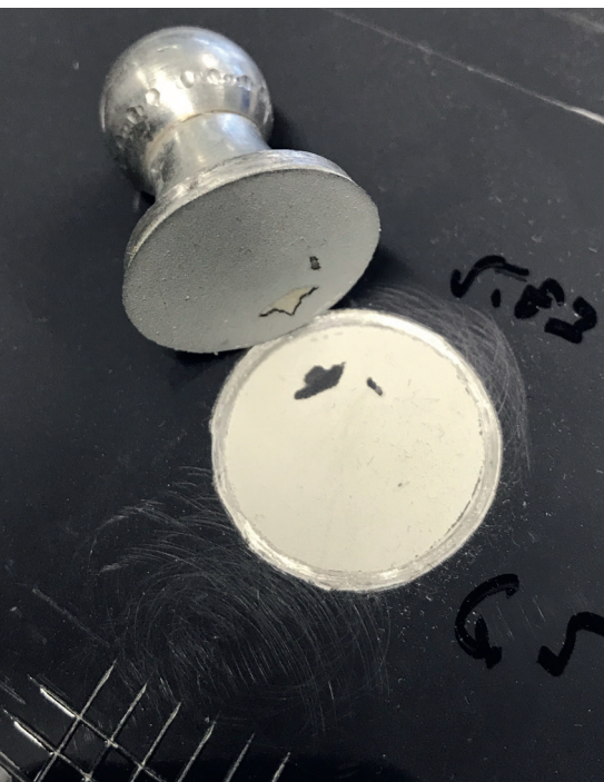
Der Stempelabriss zeigt auf, wie es um die Haftzugfestigkeit steht.
