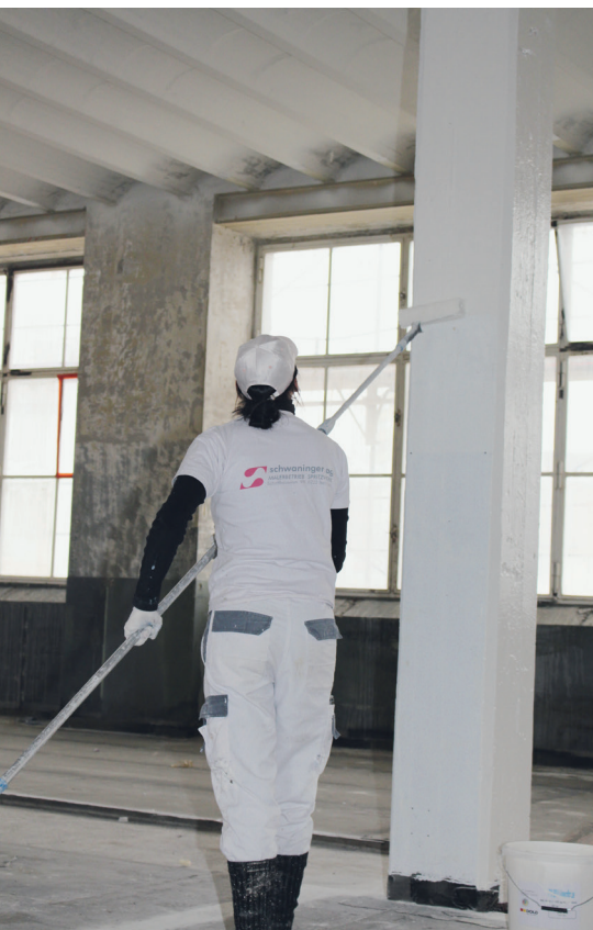
Eine Mitarbeiterin der Schwaninger AG bei der Rollapplikation der neuen «Rock Art» an einer Fabrikssäule.
