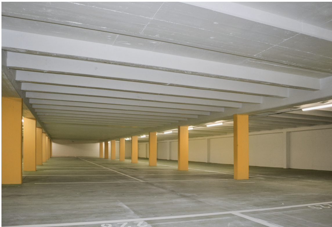
Tiefgarage Hausen bei Brugg, Brandschutzbeschichtung R60.
