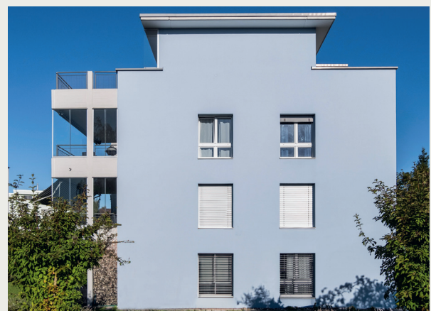
Fassade nach fachgerechter Renovierung auf Basis einer vorangegangenen Untergrundanalyse.
