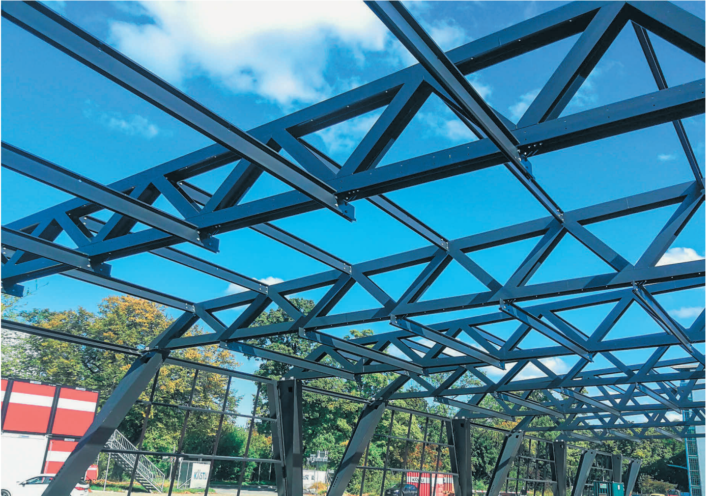
Aufbau der werkseitig beschichteten 15 000m 2 Stahloberfläche.
