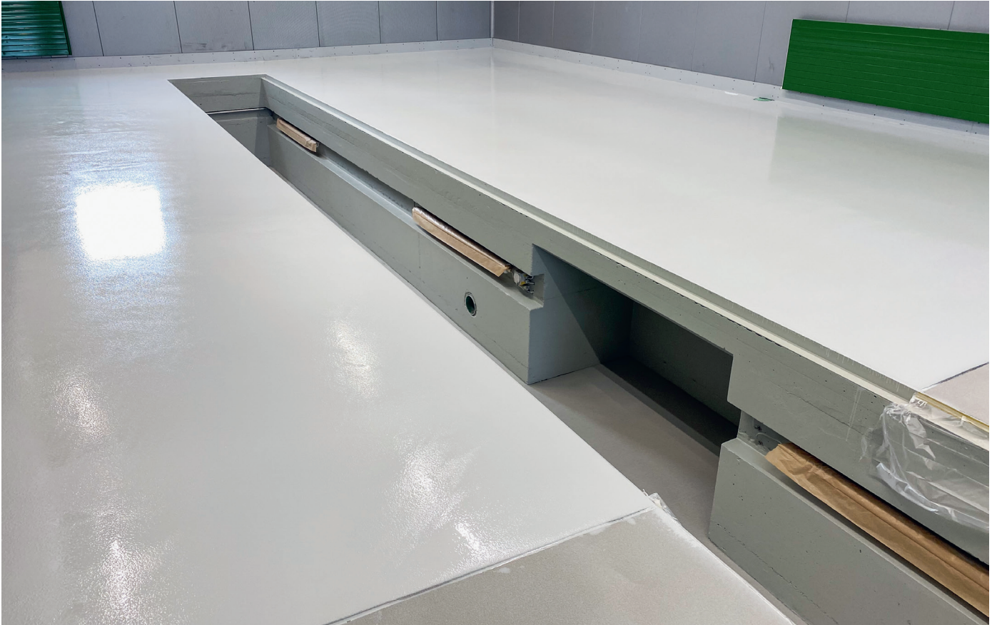
Fertige Bodenbeschichtung mit Zusatz und Absanden mittels Quarzsand.
