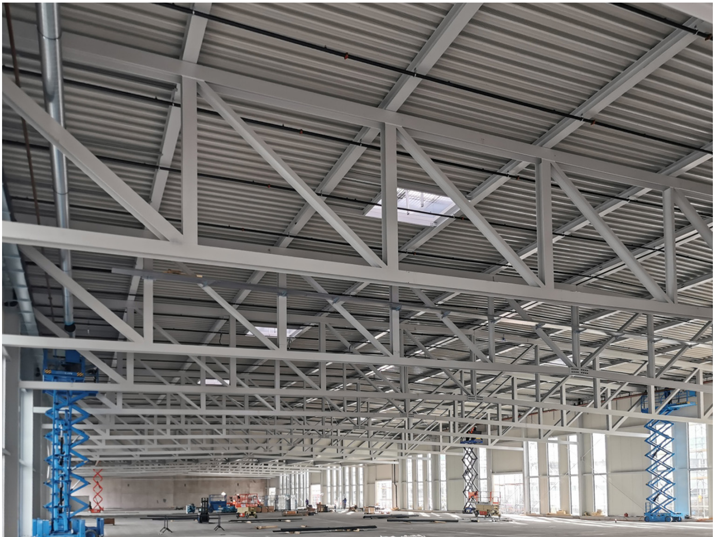
Neubau Coop, Buchs (ZH)
