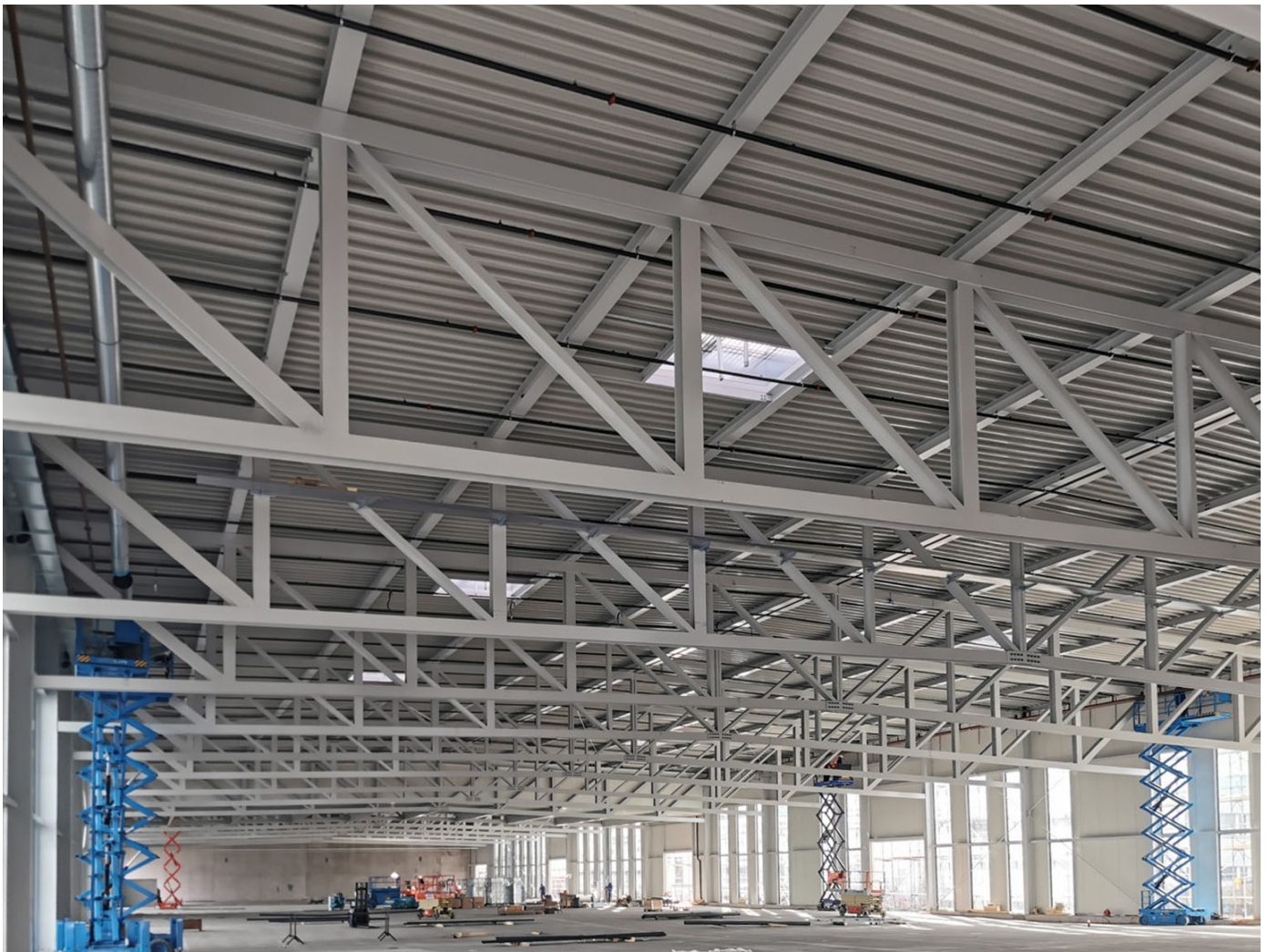
Neubau Coop, Buchs (ZH)
