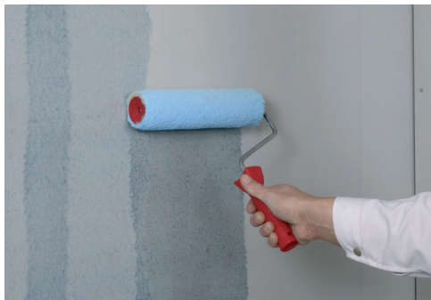
Abb. 1: Aufbringen des fermacell Tiefengrund
