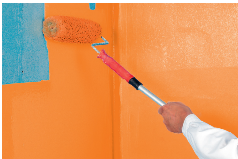
Abb. 4: fermacell Flüssigfolie mit der Rolle 2x flächig auftragen (Gesamtstärke min. 0,5 mm)
