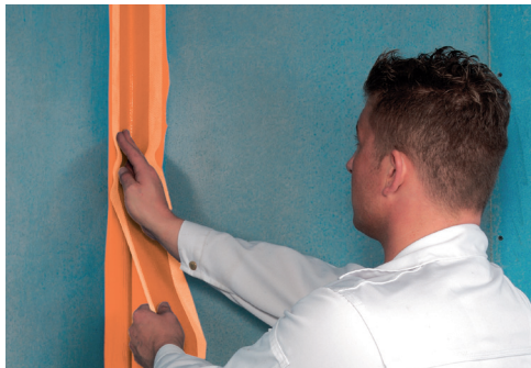
Abb. 2/3: fermacell Dichtband in die noch feuchte fermacell Flüssigfolie drücken und direkt mit Flüssigfolie überstreichen
