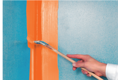
Abb. 2/3: fermacell Dichtband in die noch feuchte fermacell Flüssigfolie drücken und direkt mit Flüssigfolie überstreichen
