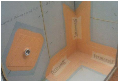
Abb. 7: Anschauungsbeispiel Boden-Wand, Wand-Wand, Dichtungsmanschette
