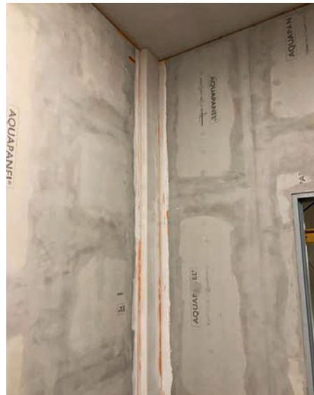
Abdichtung und Fugenausbildung: Der Teufel steckt bekanntlich im Detail.
